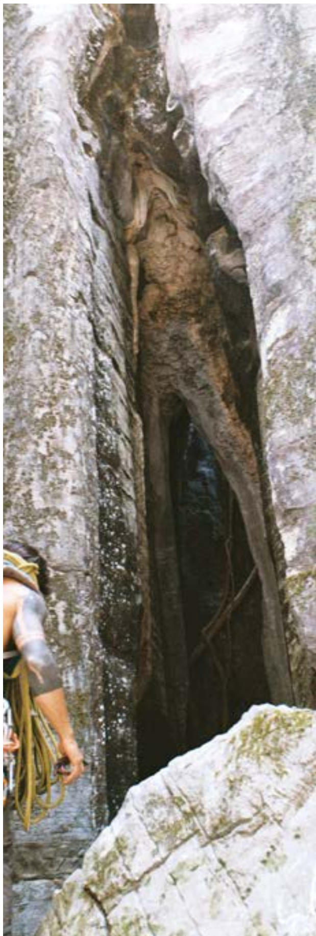
Entrada do acesso 2
